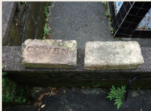
図2 白糖工場で使用された耐火レンガ 白糖工場で使用された耐火煉瓦は、一部が今も現地に放置されている。右は「COWEN」、左は「STEPHENSON」と表面に刻字されている。
