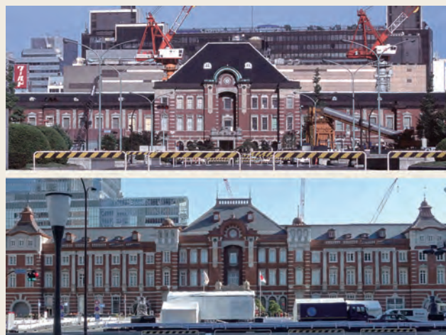
図4 東京駅丸の内駅舎(上:1994年,下:2012年)
