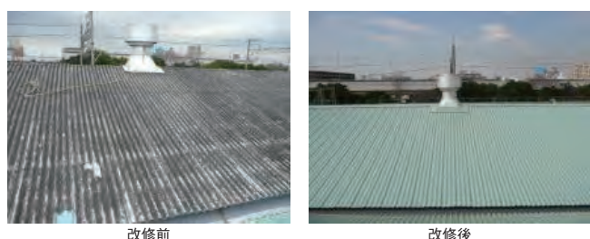
写真1 スレート屋根の改修
