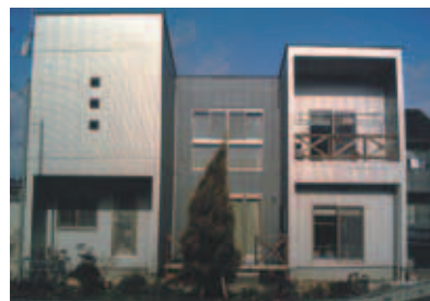
地区：福島県 応募社名：光和建材㈱ 施主：H邸 講評：凹凸部を強調し、建物形状にメタル特徴を生かした近代的建物仕上げ。
